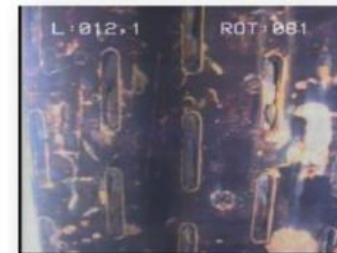
Colmatages de type physicochimique (hydroxyde de manganèse, incrustation d'hydroxyde de fer et de carbonates, corrosion par piquage)
