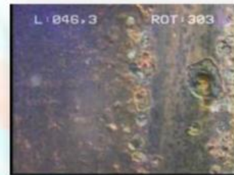
Colmatages de type physicochimique (hydroxyde de manganèse, incrustation d'hydroxyde de fer et de carbonates, corrosion par piquage)
